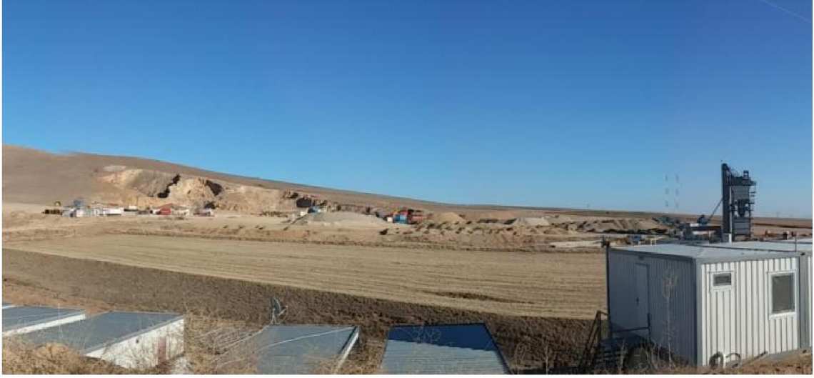
Şekil 7.75. Mucur hazır beton işletmesi taş ocağı görünümü
