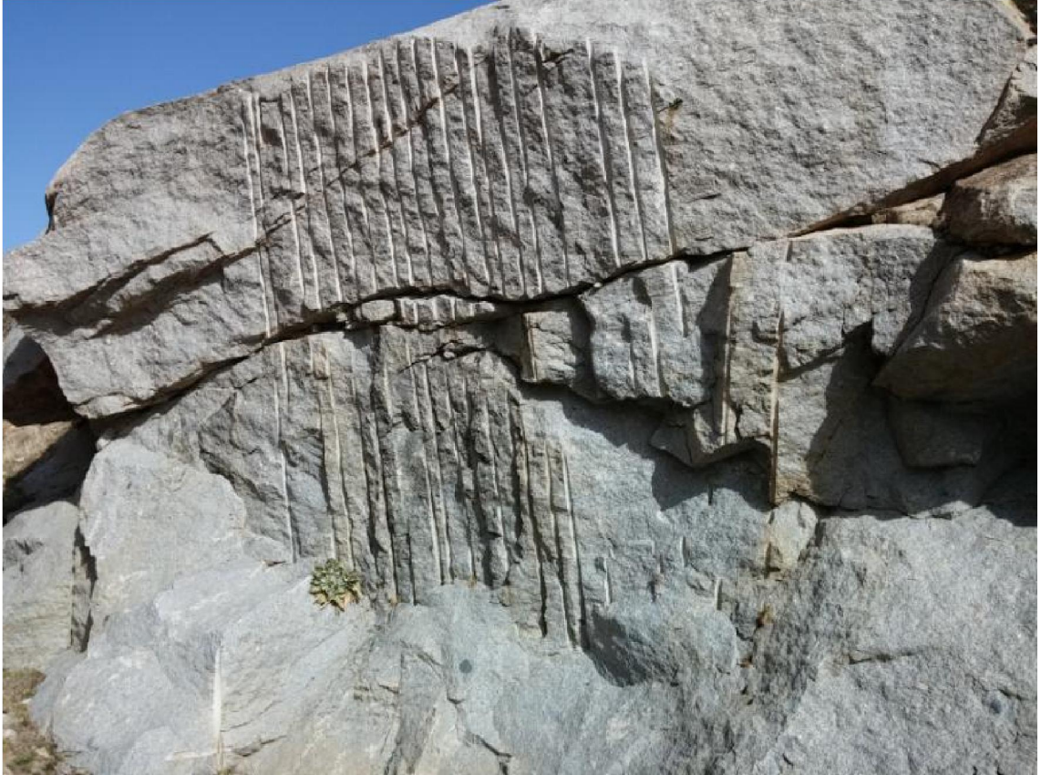
Şekil 7.23. STFA Holding'e ait Ömerhacılı'nın 2 km KD'daki granit ocağı ayna görünümü
