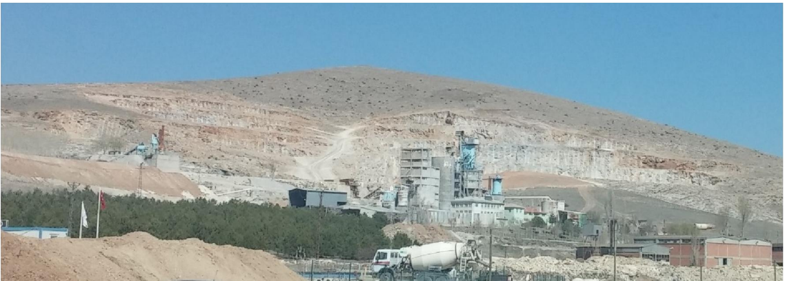
Şekil 7.58. Çayağzı bölgesi Özsarılar Madencilik'e ait kalker ocağı görünümü
