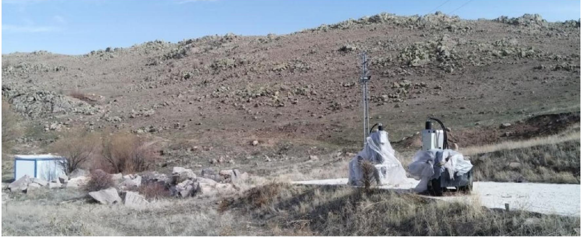
Şekil 7.10. Hamit-İsahocalı sahası Eşrefli Ocağı parke taşı üretim tesisi
