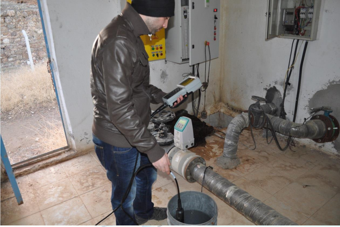
Şekil 11. Karakurt Bölgesi Kurutma Tesisi Sıcak Su Kuyusu Örneklemeye Çalışmaları
