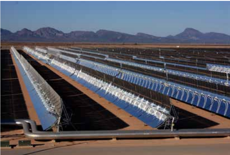
Şekil 2.18. Bir Parabolik Güç Sistemi [7]
