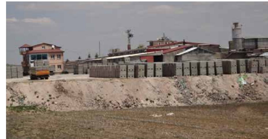
Şekil 2.19: Bimsblok üreten tesislerden tipik bir görünüm
