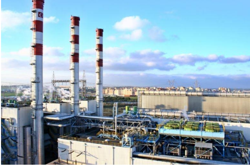
Fotoğraf 11 Esenyurt Kojenerasyon Santrali
