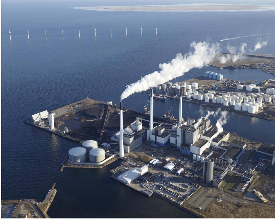
Fotoğraf 10 Kopenhag Bölgesel Isıtma Sistemi Kaynak Santrali
