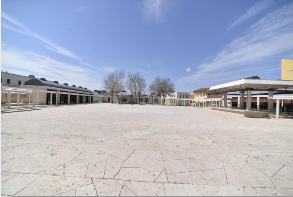
Ahi Evran Külliyesi Bahçesi / Müze Girişi
