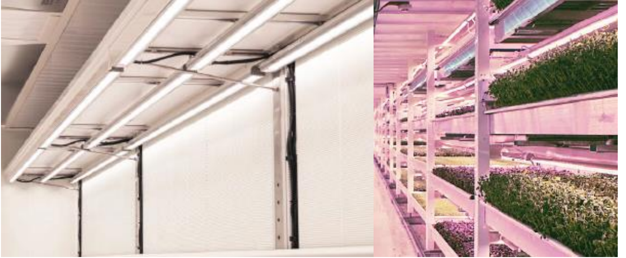
Şekil 1.5. LED Aydınlatma Sistemi
