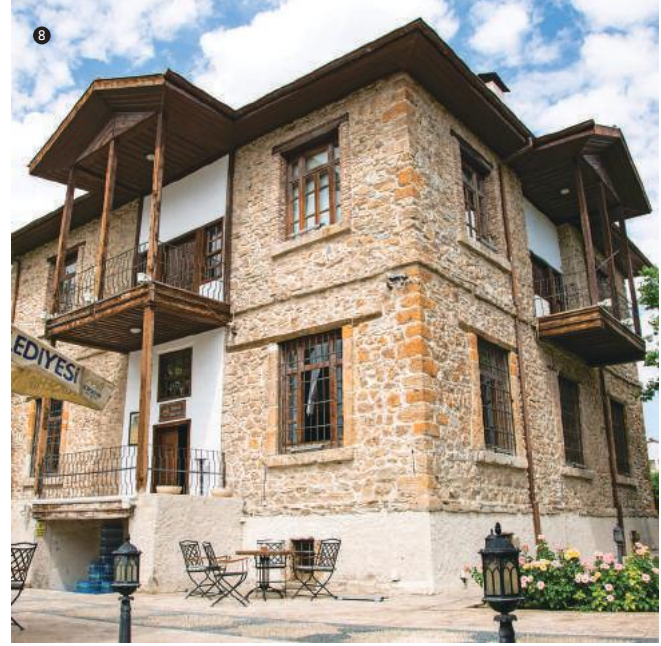
8 Taştan yapılmış geleneksel Kırşehir evleri iki katlı ve iç sofalı bir planla inşa edilmiş. Traditional Kırşehir stone houses are built with a plan of two floors and an inner courtyard.
